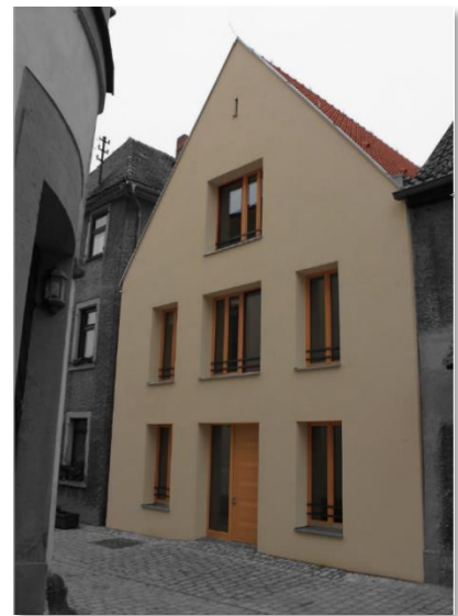
Quelle: Sachgebiet 35 Wohnungswesen, Regierung v. Unterfranken
